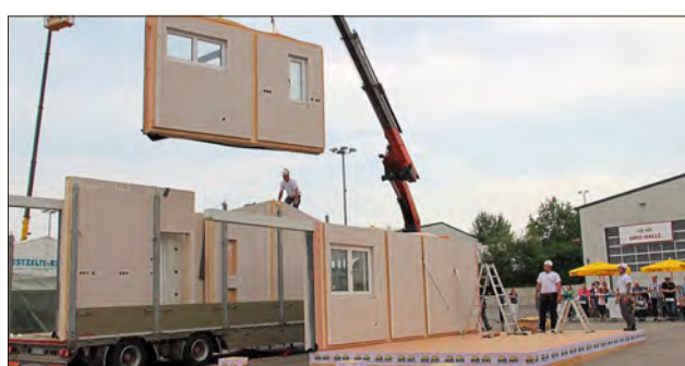
Schaumontage: So schnell steht ein Fertighaus.
